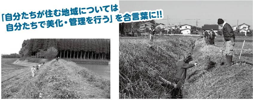
資源向上支払交付金では、水路・農道等の施設の軽微な補修。老朽化が進む農地周りの農業用排水路、農道などの施設の長寿命化のための補修・更新等の活動を支援しています。
